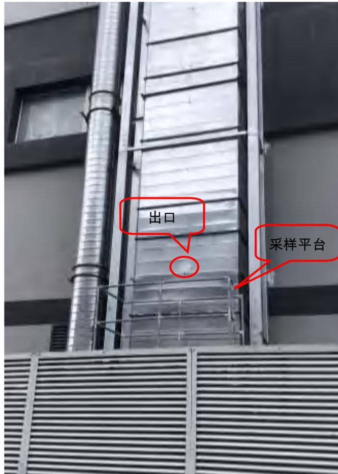
图 4-6 采样进口、出口及采样平台照片
