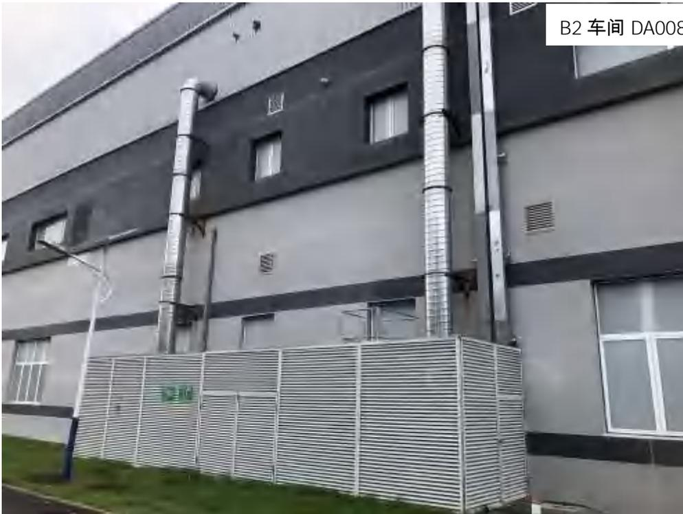
图 4-5 有机废气处理设施
